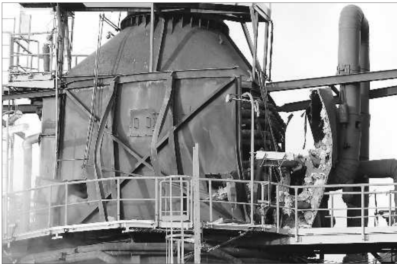
Le souffle de l'explosion a sérieusement endommagé le vapocraqueur n° 1, à l'arrêt jusqu'à nouvel ordre.
