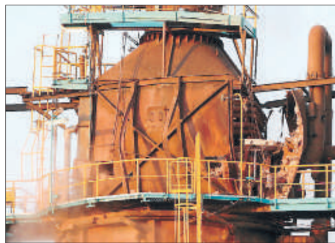
Le haut du surchauffeur, four à vapeur du vapocraqueur, totalement éventré par l'explosion.
