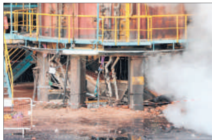
Toutes les briques réfractaires qui tapissaient l'intérieur du four sont tombées sur les opérateurs occupés au pied du vapo.
