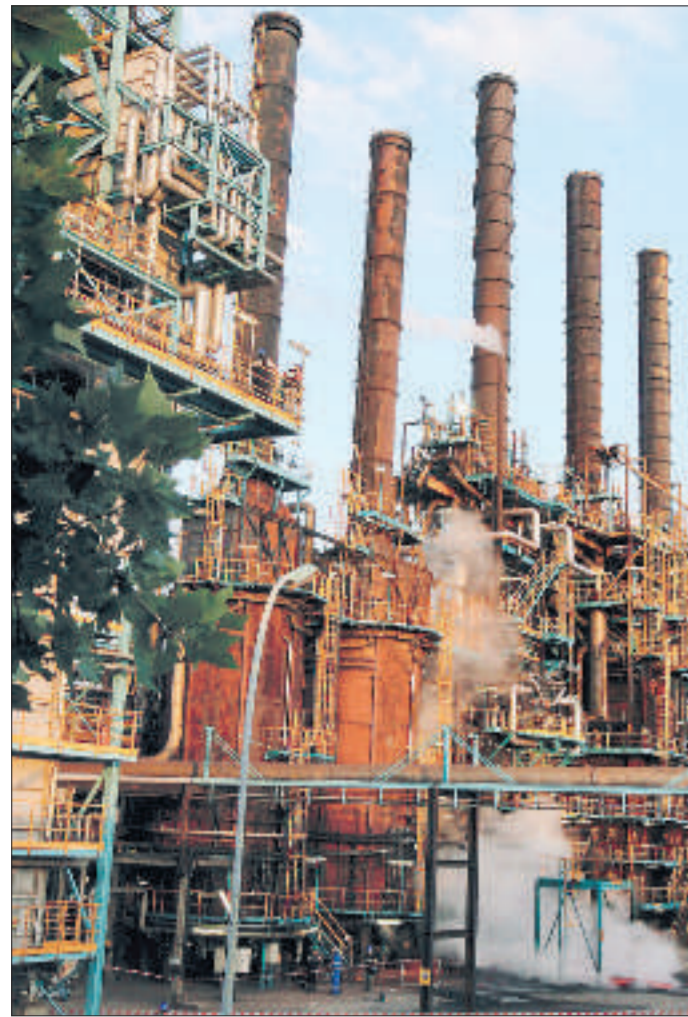
15 h mercredi 15 juillet : une explosion survient au niveau du vapocraqueur n°1 du site chimique de Carling, sur un four à vapeur. Bilan : deux morts et six blessés. « Le vapo 1 n'est pas vétuste, selon la direction de l'usine, il a subi une révision complète en 2007 et son état avait été jugé excellent ».
